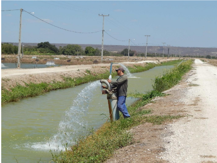
Figura 14 – Água subterrânea armazenada no canal de abastecimento de fazenda de produção de L. vannamei em águas oligohalinas na cidade de Limoeiro do Norte - CE.
