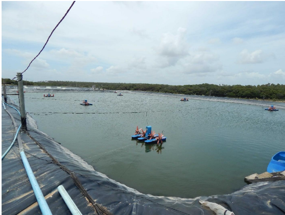
Figura 16 – Viveiro de produção de L. vannamei em águas oligohalinas, revestido com geomembrana de PEAD, abastecido com água de rio em Ceará Mirim – RN.
